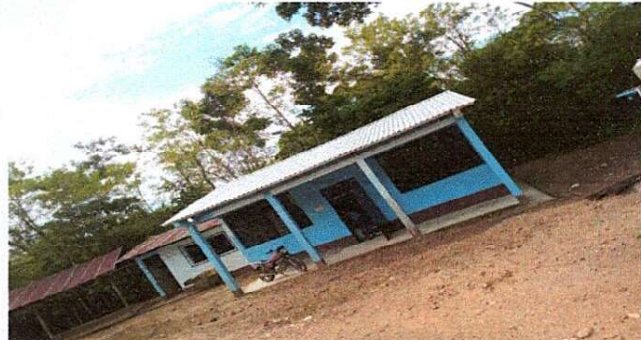
Foto 2: Reglón numero 2 se modificó para cubierta de lámina y estructura de techo para la dirección-bodega concluida.
