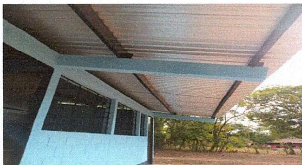
Foto1: Cubierta de lámina instalada.
