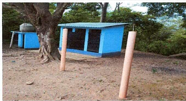
Foto 4: Reglón numero 7 se realizó la modificación para cubierta de lamina, estructura de techo, pintura en muro interior y exterior para los 5 baños concluido.
